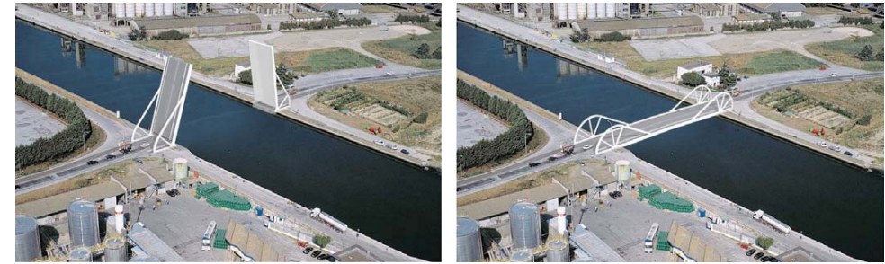
Fig. 3. Ponte mobile sul Canale Candiano a Ravenna: immagini con la struttura aperta e chiusa (fonte Comune di Ravenna).
