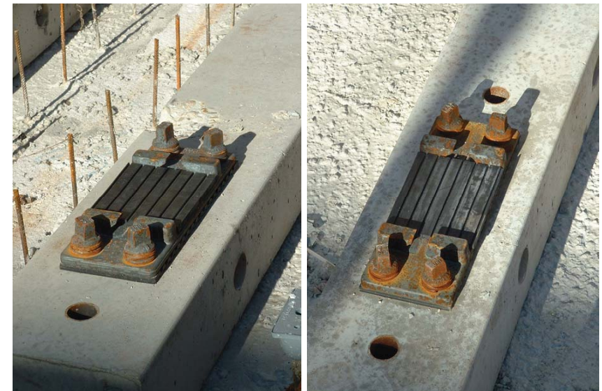
Fig. 9. Roma, particolare dei lavori di posa in opera del nuovo armamento lungo via Labicana (foto A. Spinosa).
