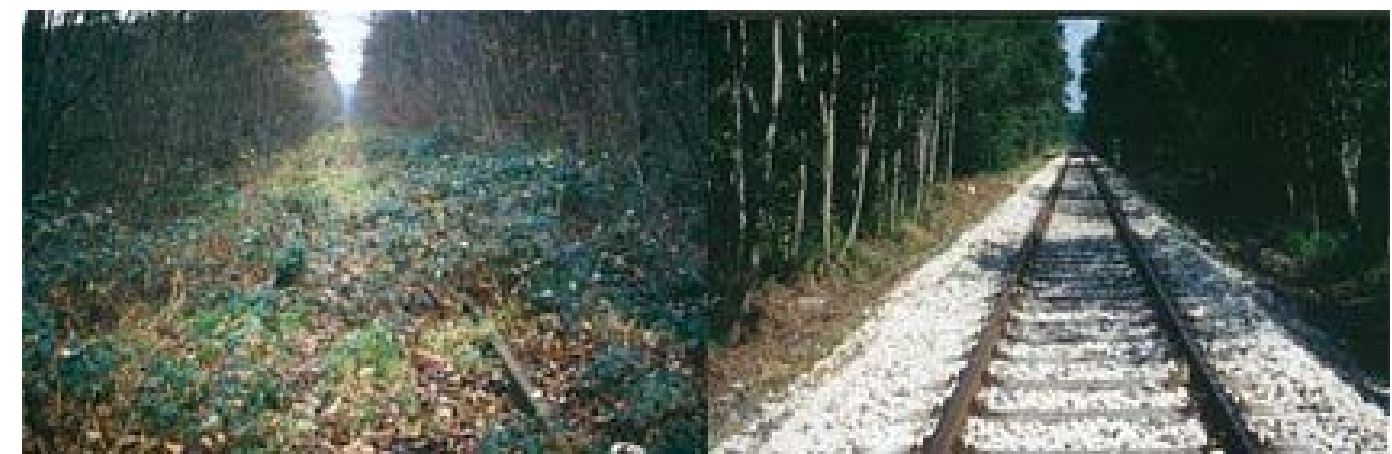
Fig. 9. La sede ferroviaria prima e dopo l'intervento.
