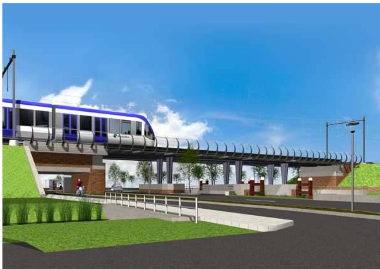
Tratta Leidschendam-Voorburg: lasciata la stazione centrale de L'Aia il servizio opera su tratta ferroviaria trasformata con via di corsa in rilevato alto.
