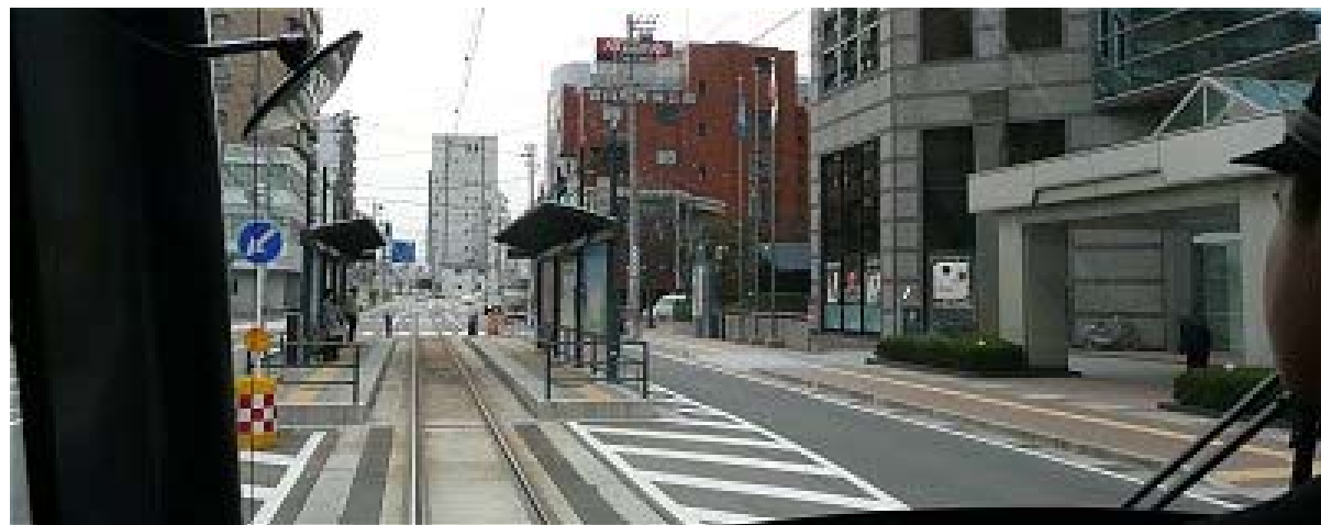
Il nuovo tracciato tranviario con piattaforma di fermata su entrambi i lati del binario.
