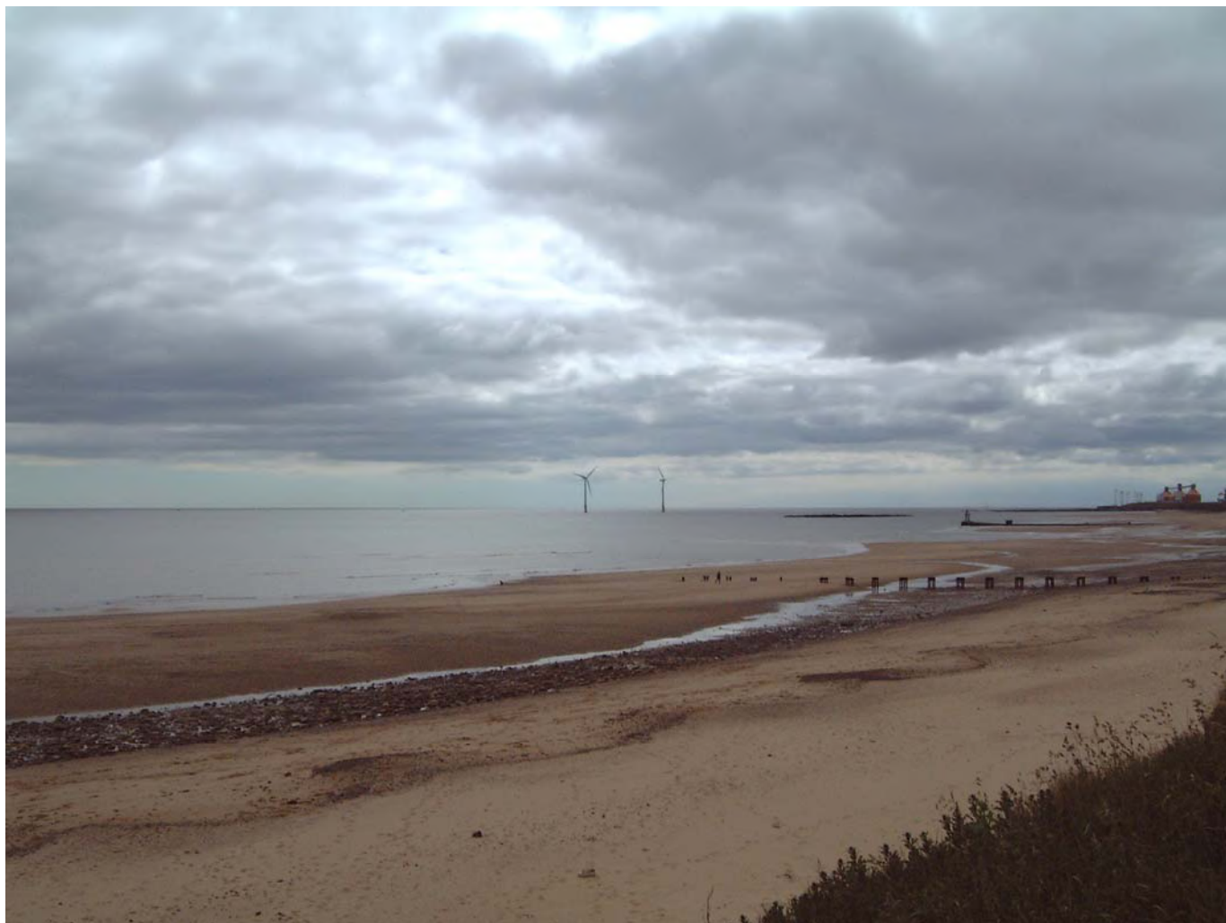
Fig. 27. Impianto offshore: vista dalla spiaggia.
