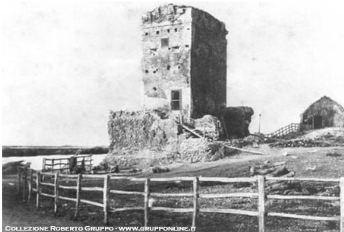
Fig. 5. La Torre Boacciana.
