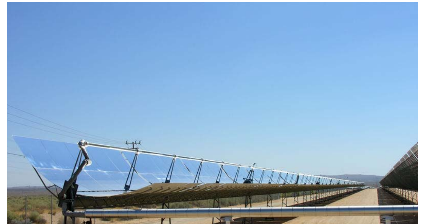
Fig. 29. Gli specchi concentrano la luce sul tubo centrale termovettore.
