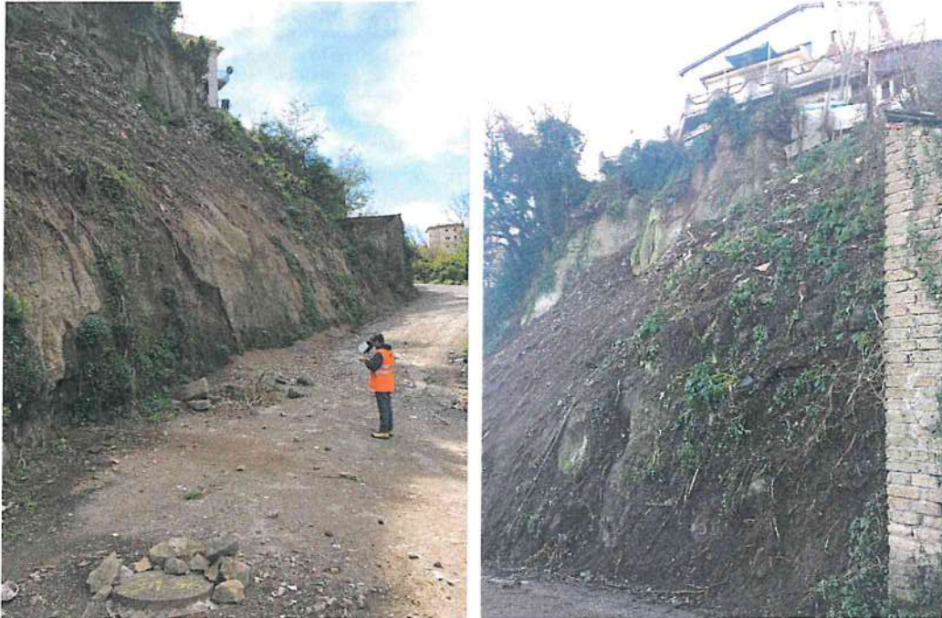
Figura 2. Panoramica del versante da consolidare
