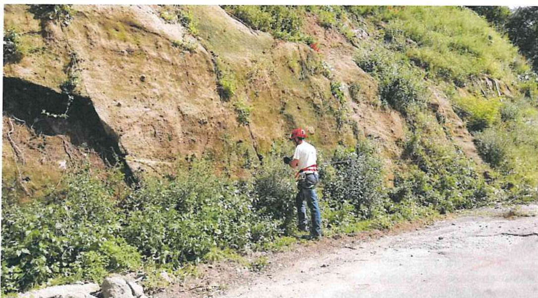
Figura 13. Ubicazione di una stazione geomeccanica
