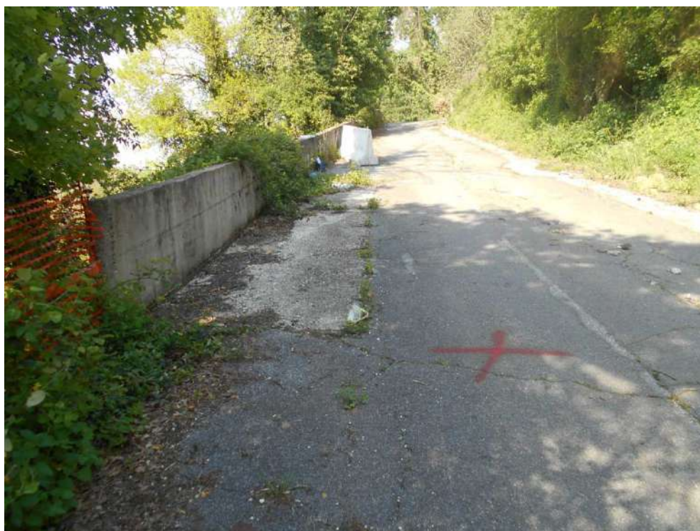
Foto 2: Porzione di Via delle Fontanelle da consolidare
