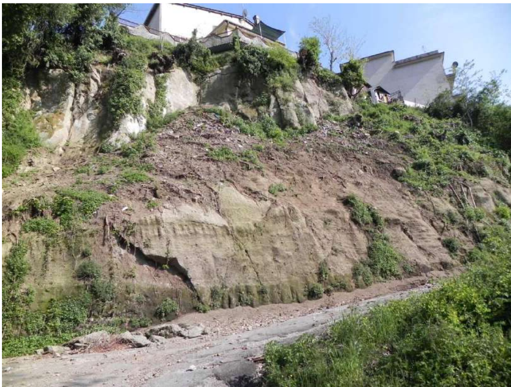
Foto 4: Versante e edificio posto in sommità
