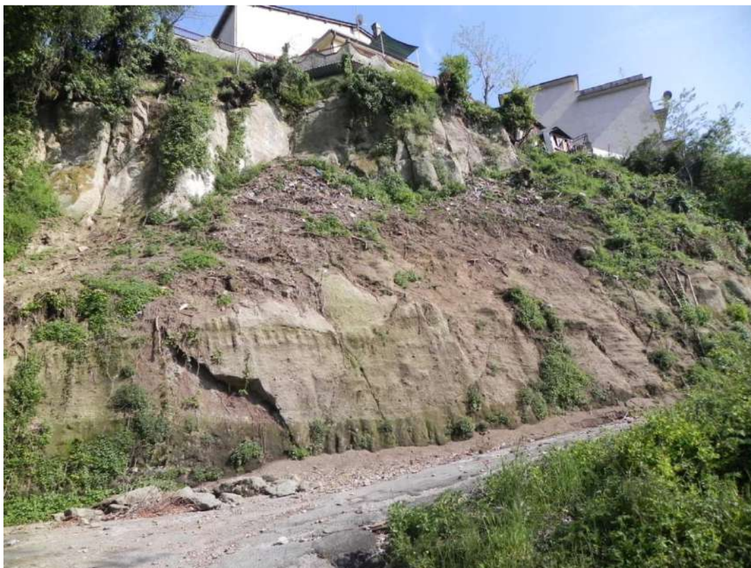
Foto 1: Vista generale del versante
