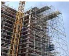
Il ponteggio fisso è un'opera provvisoria realizzata per eseguire lavori ad altezze superiori ai 2 metri. Si tratta di una struttura reticolare realizzata con elementi metallici.
