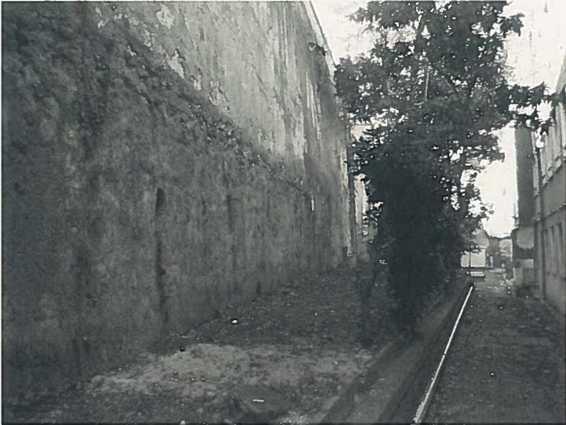
Foto 1 - Vista del muro sul lato cortile interno scuola
