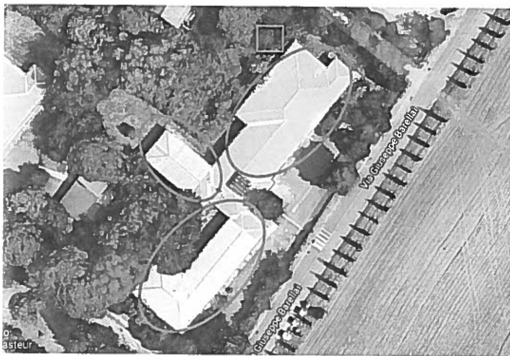
Foto 3 – padiglione "I" con individuazione delle falde a lamiera indicate negli ovali.
