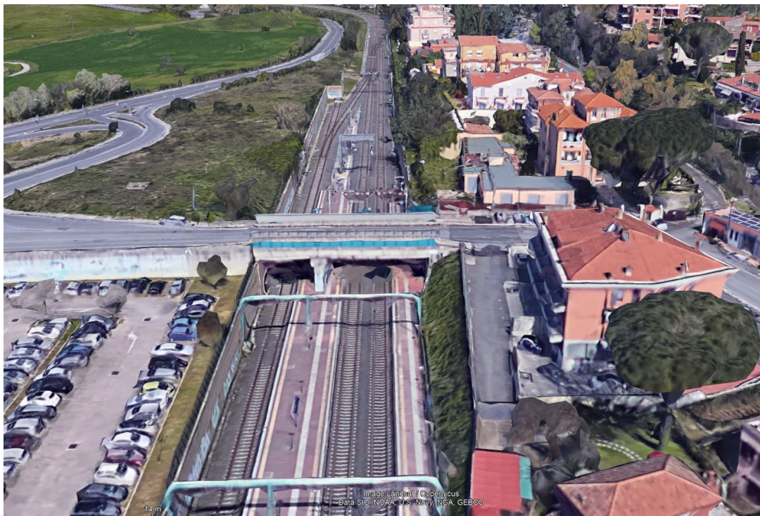
Figura 7) Ponte attraversamento ferrovia Roma-Viterbo.
