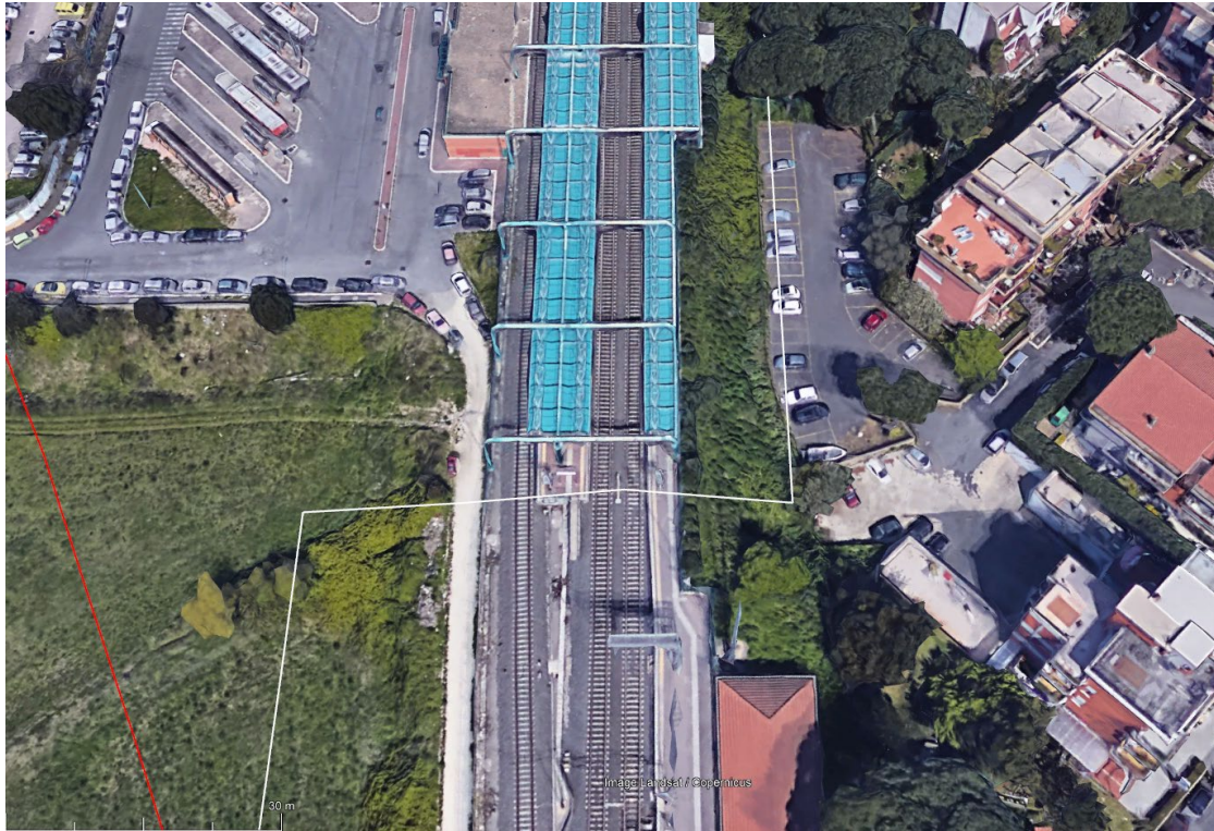
Figura 9) Punto di attraversamento ferrovia in perforazione.
