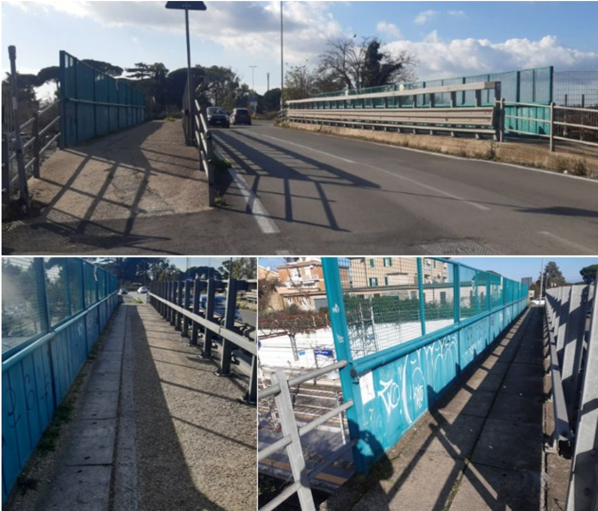
Figura 8) Cunicoli esistenti su ponte attraversamento ferrovia Roma-Viterbo.
