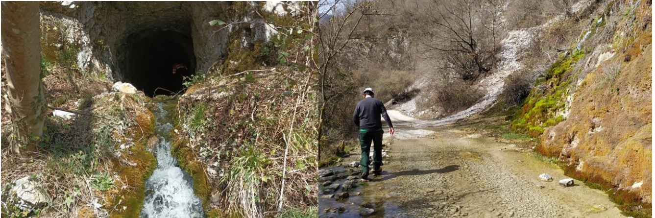
Figura 6-19 Venuta d'acqua dalla finestra (a sinistra) e interessamento della strada (a destra)
