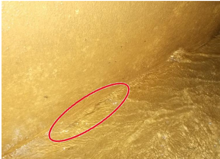
Figura 6-15 Interno del ponte canale con dettaglio sulla fessurazione
