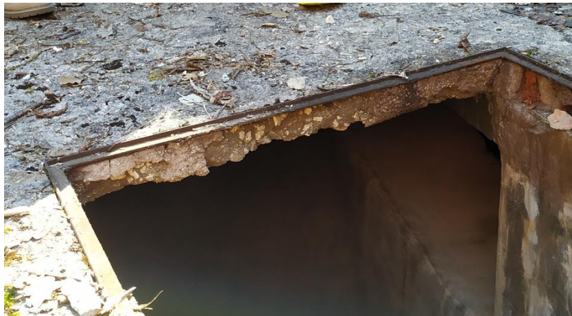
Figura 6-13 Soletta di copertura della diramazione del canale di scarico
