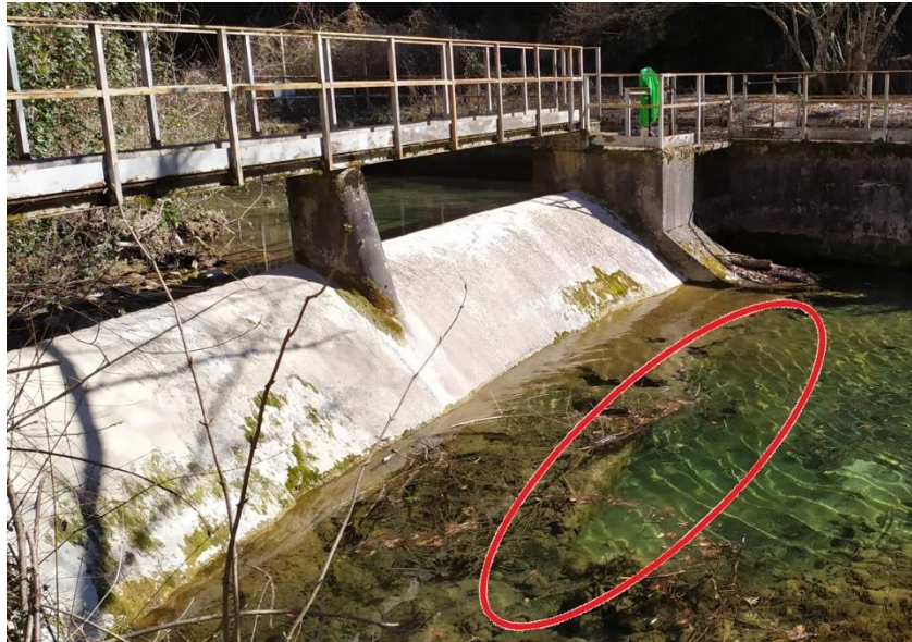
Figura 6-9 Traversa sul fiume Simbrivio vista da valle con scalzamento al piede
