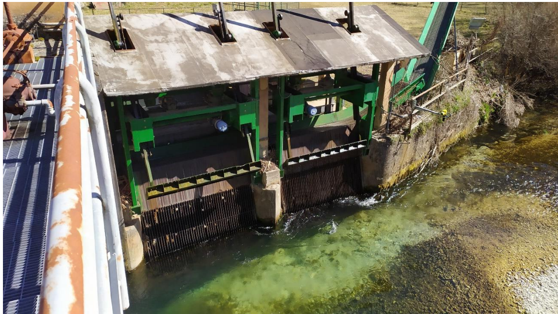
Figura 4-1 Fotografia delle griglie di presa a monte dello sbarramento sul fiume Aniene
