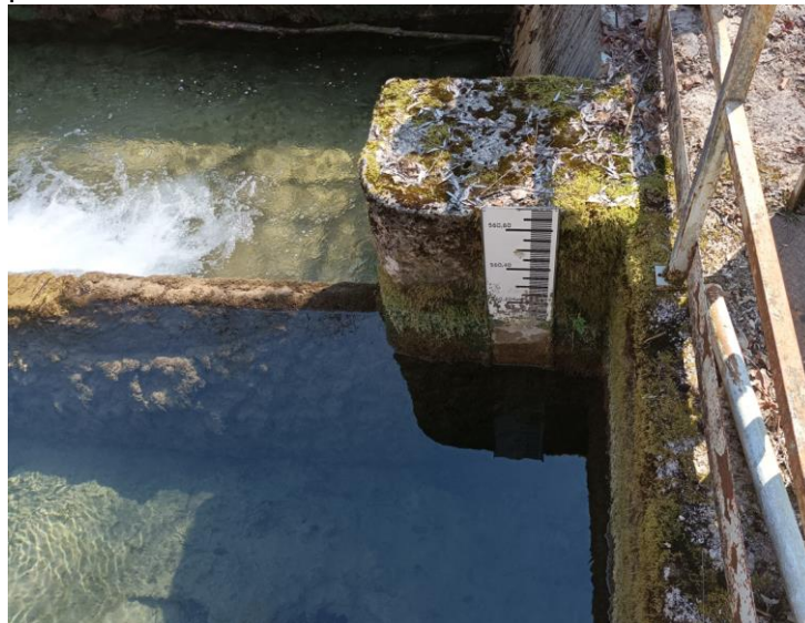
Figura 6-10 Vista di sfioratore e passerella dell'opera di presa
