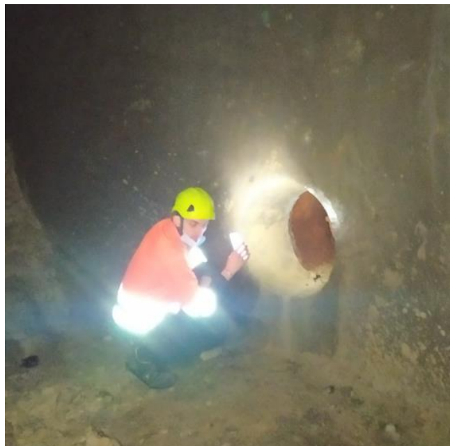
Figura 6-18 Tamponamento con passo d'uomo al termine della finestra Cerrete
