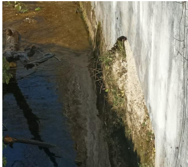
Figura 6-6 Dettaglio del distacco al piede del muro in sponda destra
