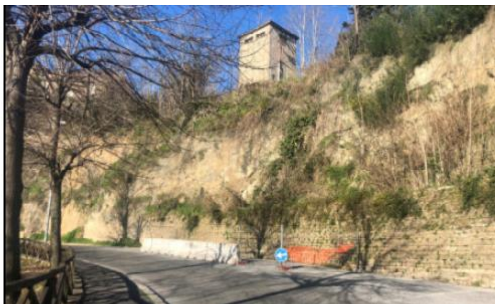
Figura 2. Parete oggetto dell'intervento
