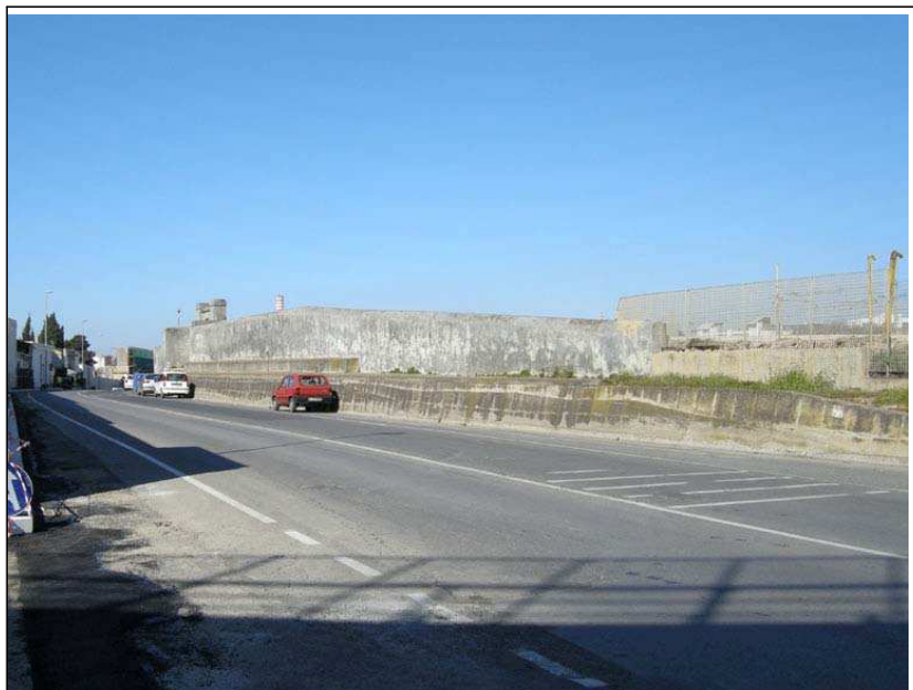
Via Aurelia Nord – recinzioni (vista altezza "Cimitero Monumentale") (4)
