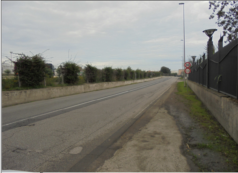
Aurelia Nord – Vista altezza Km 74+600 (3)
