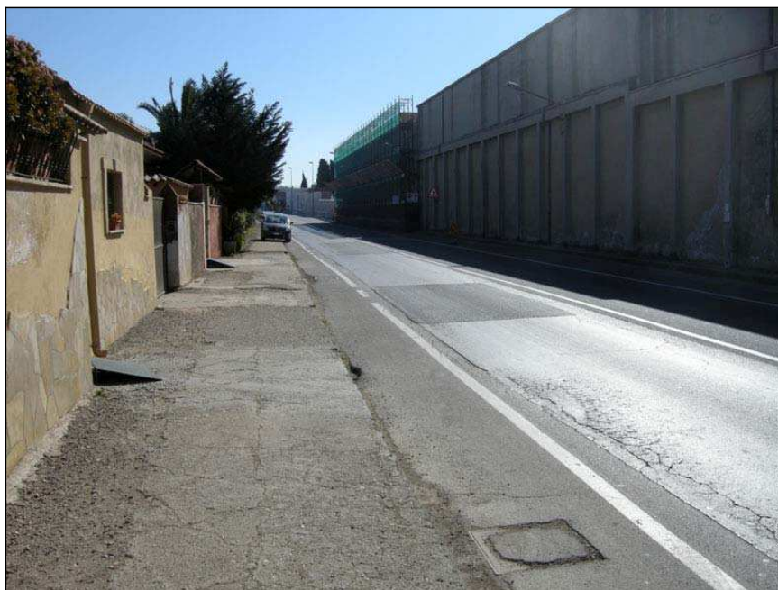
Via Aurelia Nord – vista verso Cimitero monumentale (1)
