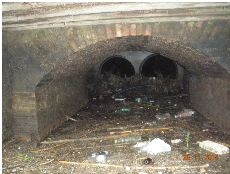
Foto n. 3– F. dei Tinozzi–Imb. attravers. via S. Maria–imb. 2 DN1000 di recente costruzione
