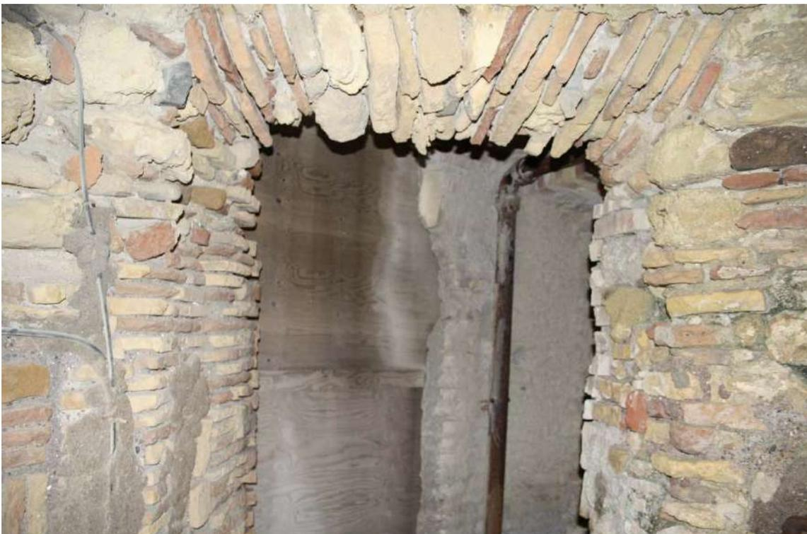
Fig. 4. Forte Sangallo, impianto idrico sanitario in stato di degrado.
