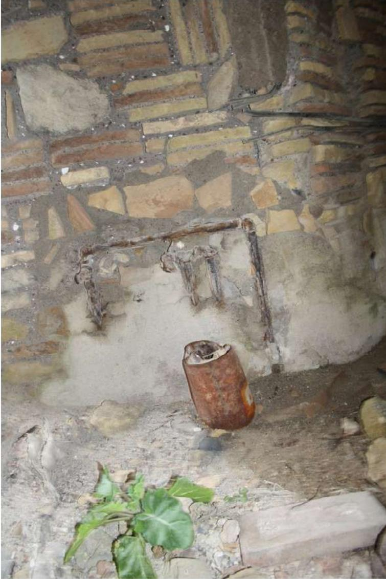
Fig. 5. Forte Sangallo, impianto idrico sanitario in stato di degrado.
