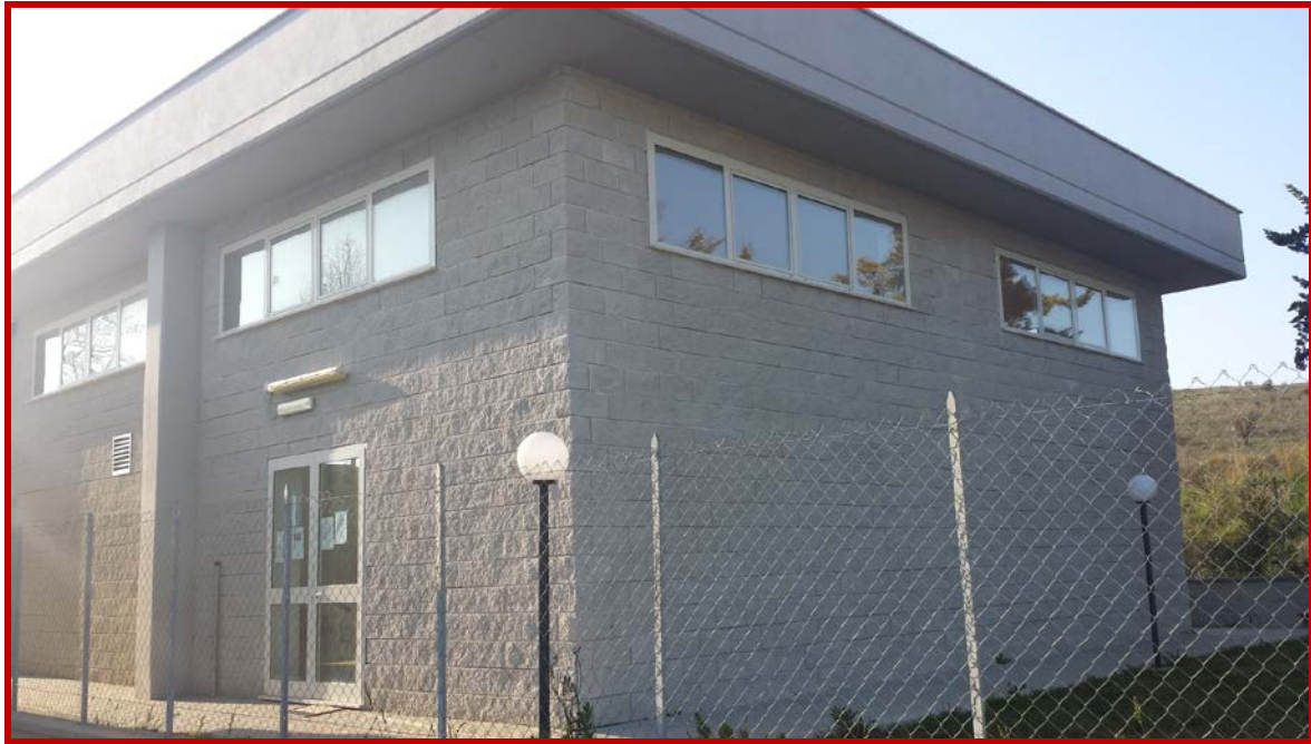
Immagine 6 – Vista prospetto A e B
