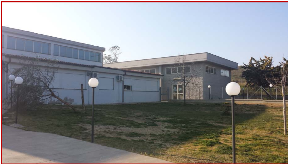
Immagine 3 – Vista prospetto B
