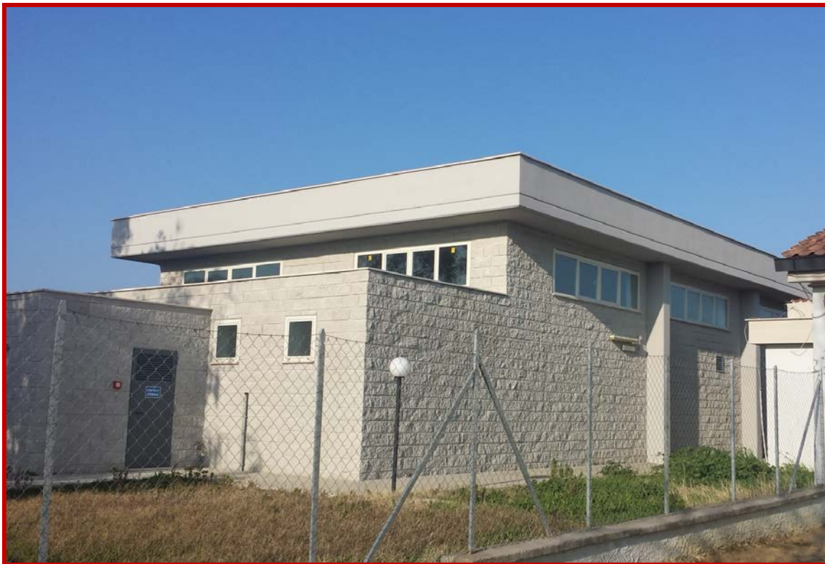
Immagine 5 – Vista Palestra e centrale termica prospetto lato D e A
