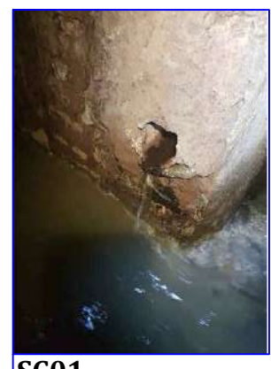
SC01 Tub. in Terracotta DN120 quota 50 cm dal piano fondo collettore
