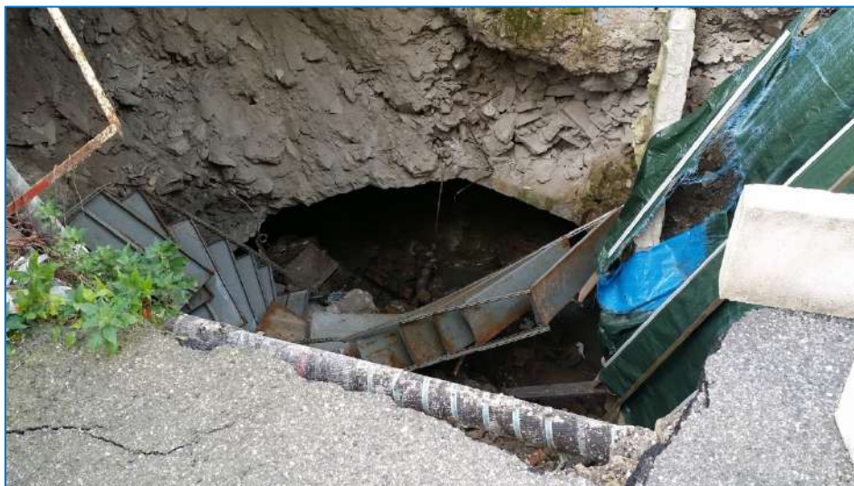
Figura 8: Materiale da rimuovere all'interno del cavo
