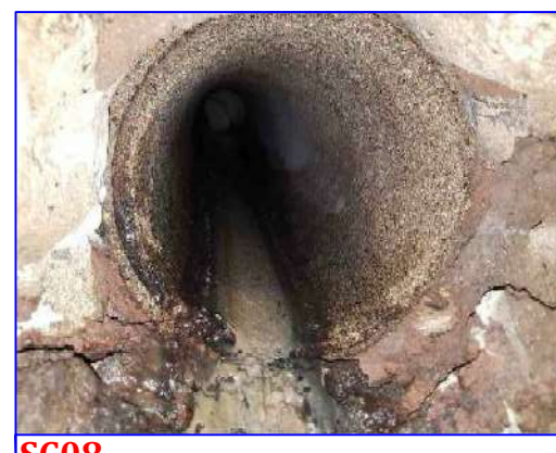
SC08 Tub. in c/c DN300 quota 110 cm dal piano fondo collettore
