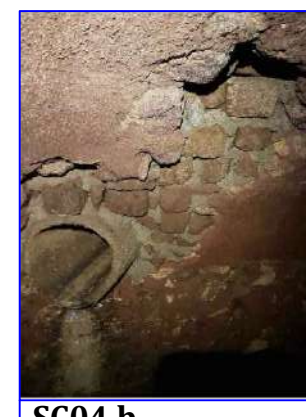
SC04 b Tub. in PVC DN300 quota 150 cm dal piano fondo collettore
