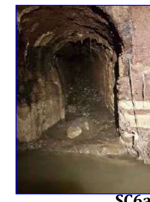
SC06a Cunicolo fognario delle dimensioni di L. 60cm e H. 70cm Il manufatto si inserisce nella galleria principale tramite un salto. Ha uno sviluppo rettilineo di 7 m circa.
