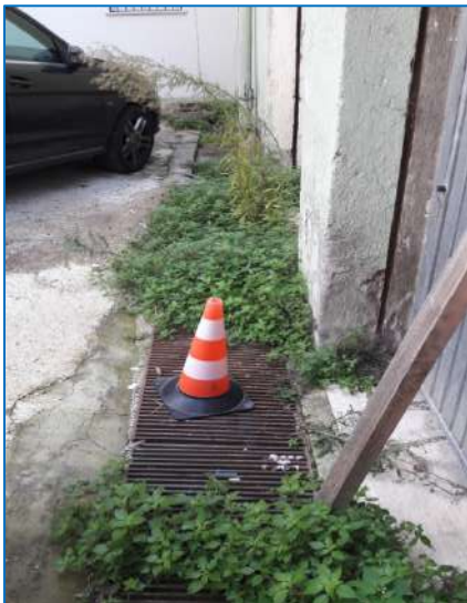
Figura 7: Griglia di raccolta acque del cortile e copertura box privati intasata
