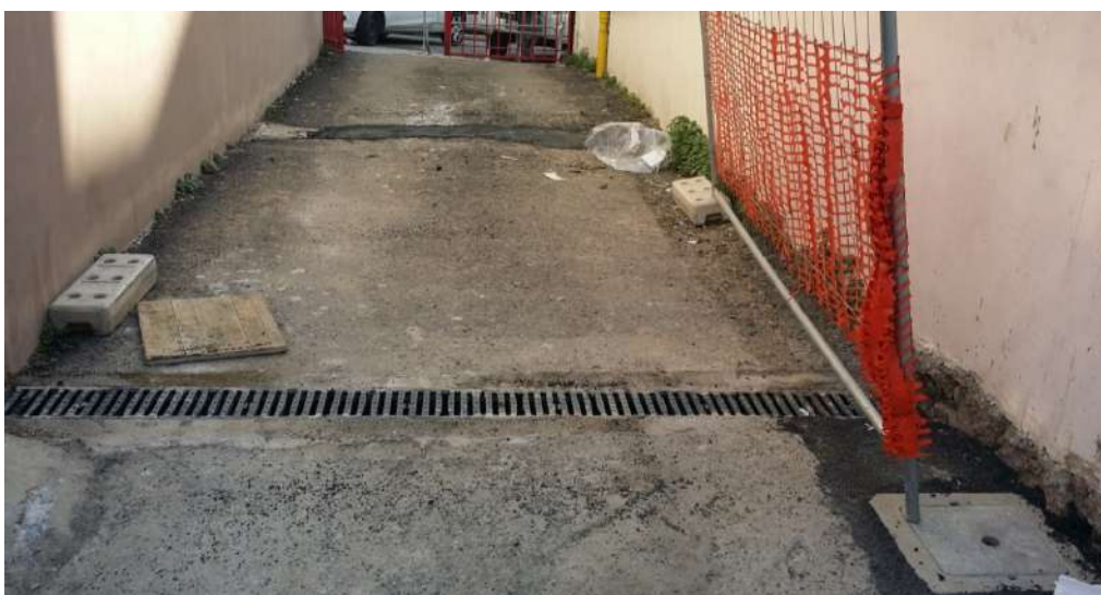
Figura 15: Griglia di raccolta acque meteoriche cortile
