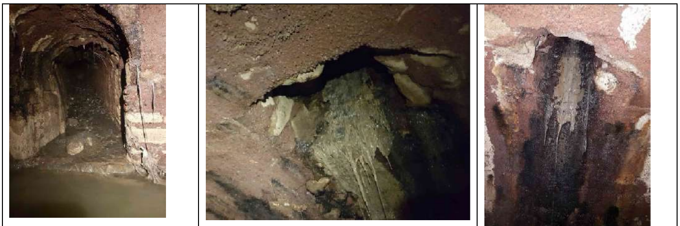
Fig. 37: Scarichi SC06a - SC06b - SC07
