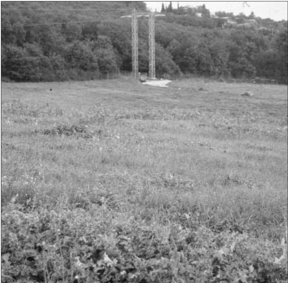
Figura 16. Linea elettrica presso un'area forestale. Foto: A. Guidi.
