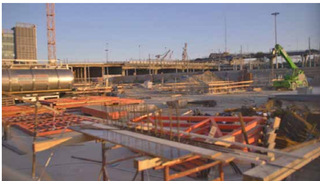
Cantiere Via Ca' Marcello
