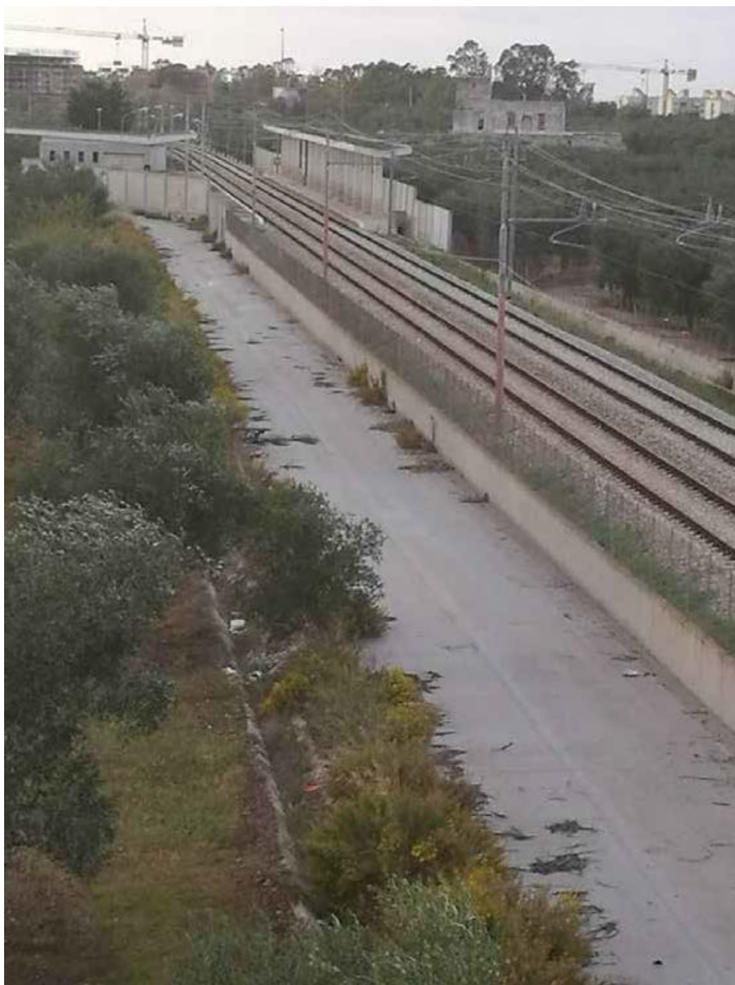
Quartieri Palese – S. Spirito – Macchie – San Pio Catino (V Municipio). Linea ferroviaria Bari - Barletta. La fermata Enzitetto (incompleta) in prossimità della Torre Ricchizzi e del relativo sito archeologico.
