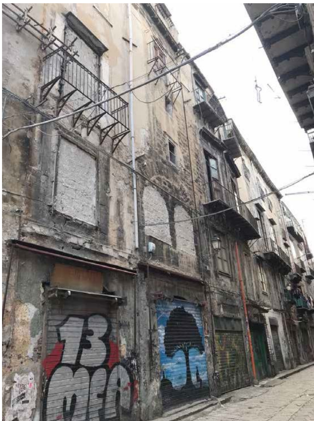
Centro storico: Vucciria - resti dei bombardamenti e del mercato storico
