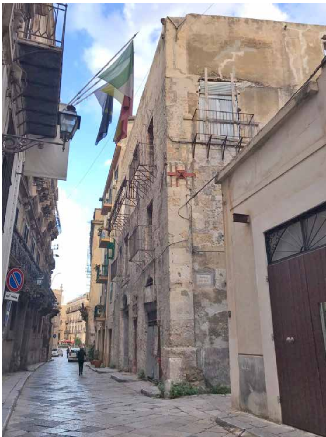
Palermo - Centro storico - sede sovrintendenza del mare
