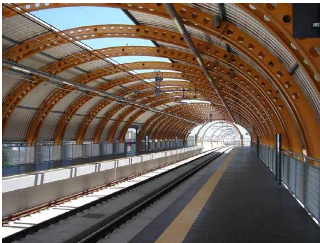
Quartiere S. Paolo. Metropolitana Bari Centrale Ospedale S. Paolo. Fermata Tesoro
