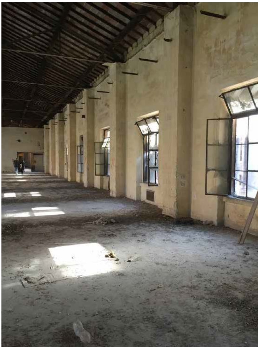
Quartiere Libertà. La Ex Manifattura dei Tabacchi, porzione destinata al CNR, primo piano
