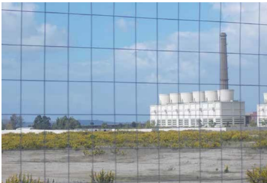
Bagnoli - area ex Italsider - torre di spegnimento
