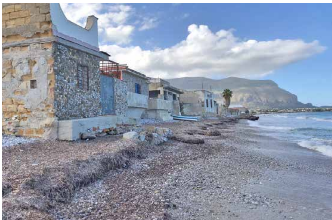
Carini - lungomare - edifici abbandonati
