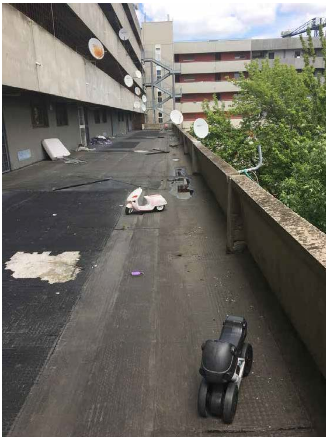
Calderara di Reno, complesso Garibaldi 2, blocchi 4, 5 e 6 oggetto di demolizione, esterno terrazze
