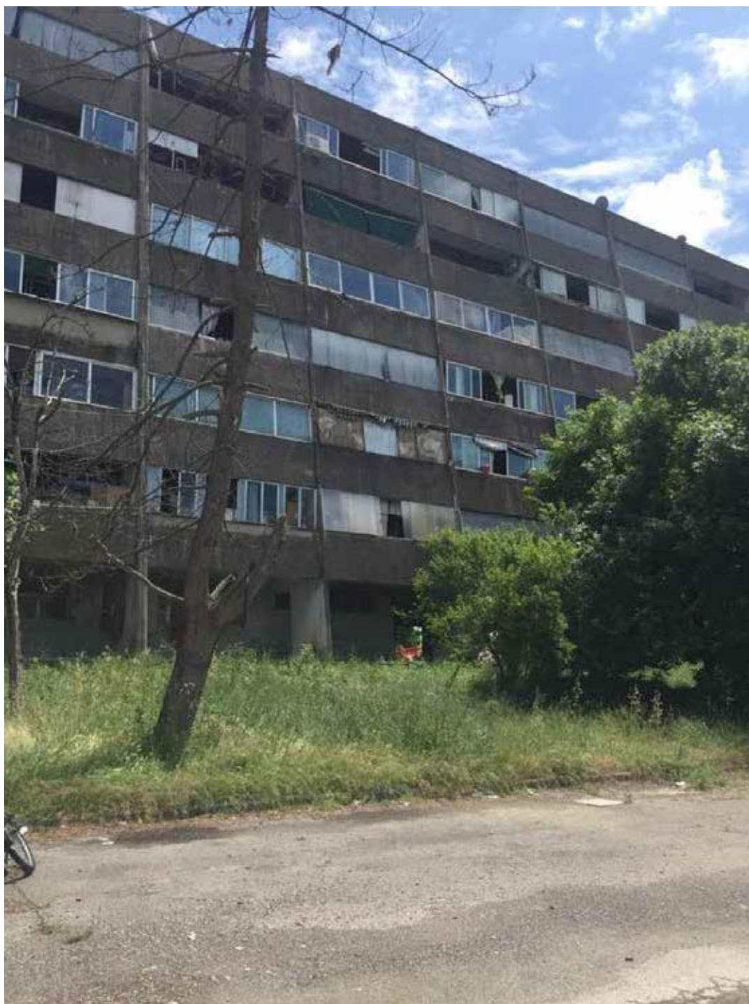
Calderara di Reno, complesso Garibaldi 2, blocchi 4, 5 e 6 oggetto di demolizione
