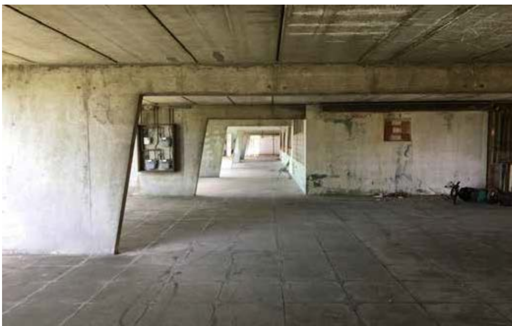
Calderara di Reno, complesso Garibaldi 2, blocchi 4, 5 e 6 oggetto di demolizione, piano terra
