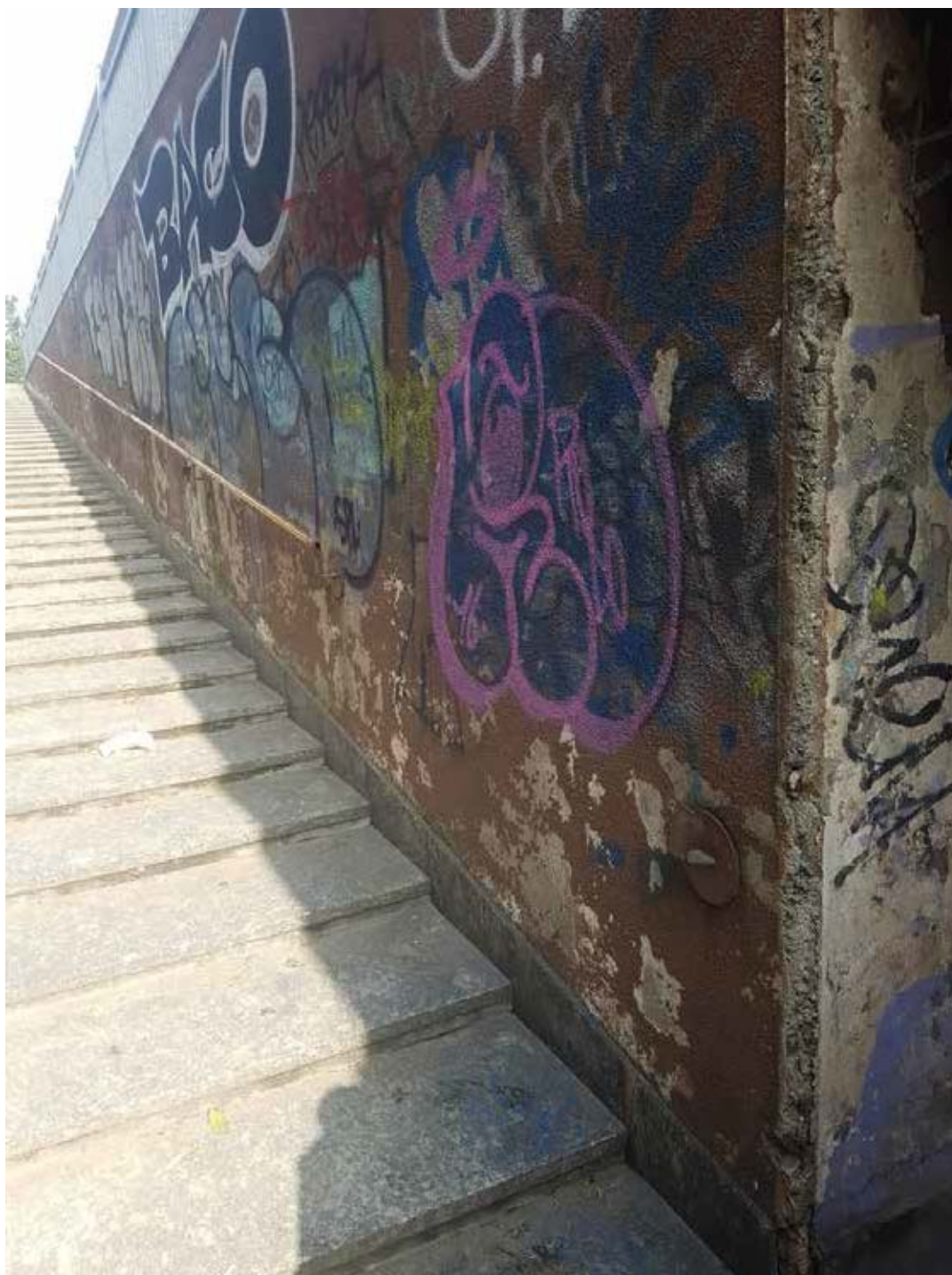
Sottopasso di Crescenzano prima dell'intervento di riqualifica
