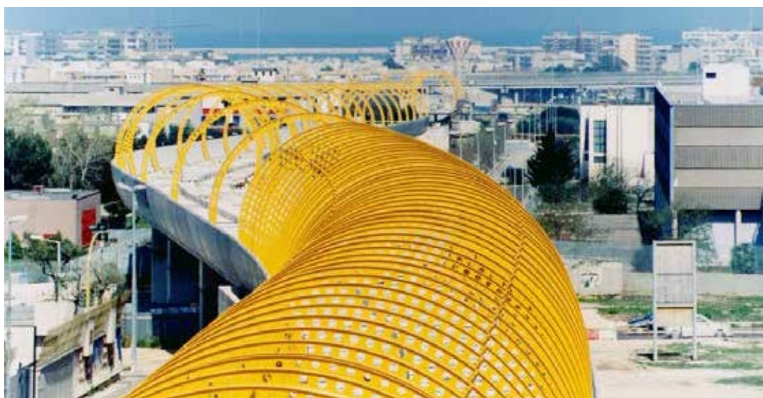
Quartiere S. Paolo. Metropolitana Bari Centrale Ospedale S. Paolo (in esercizio dal 2008). Tratto in viadotto.
