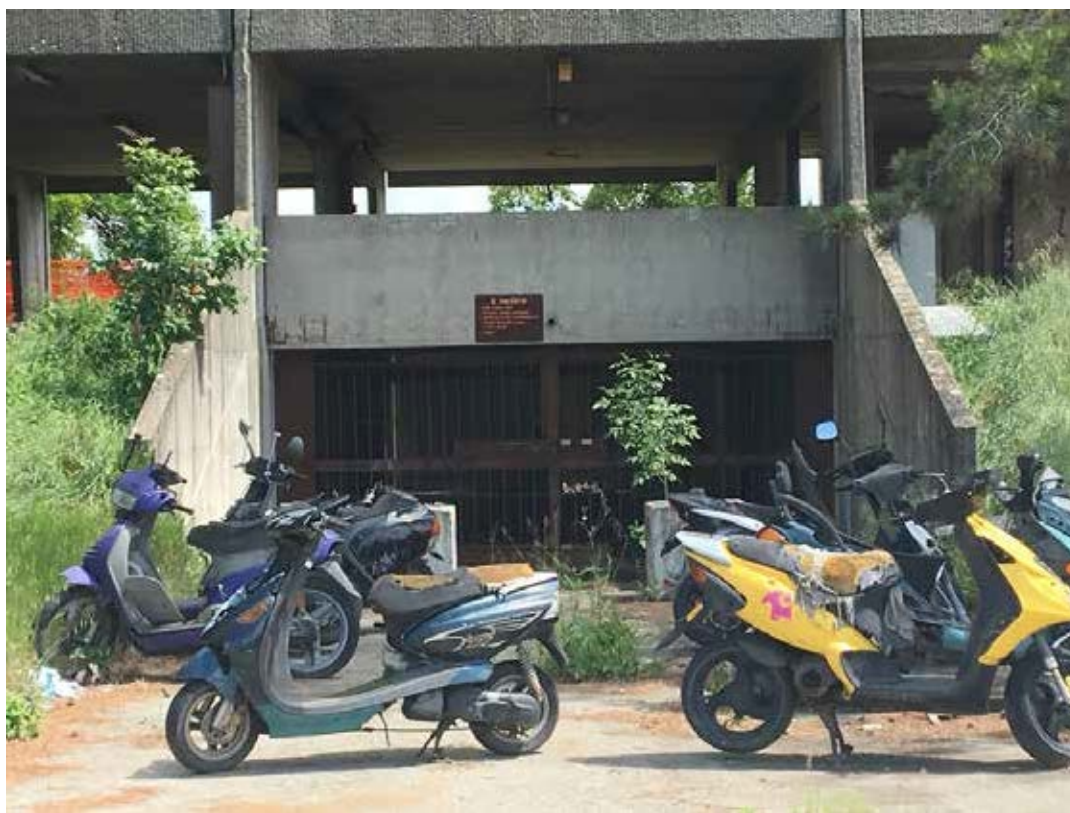
Calderara di Reno, complesso Garibaldi 2, blocchi 4, 5 e 6 oggetto di demolizione, area cortiliva esterna
