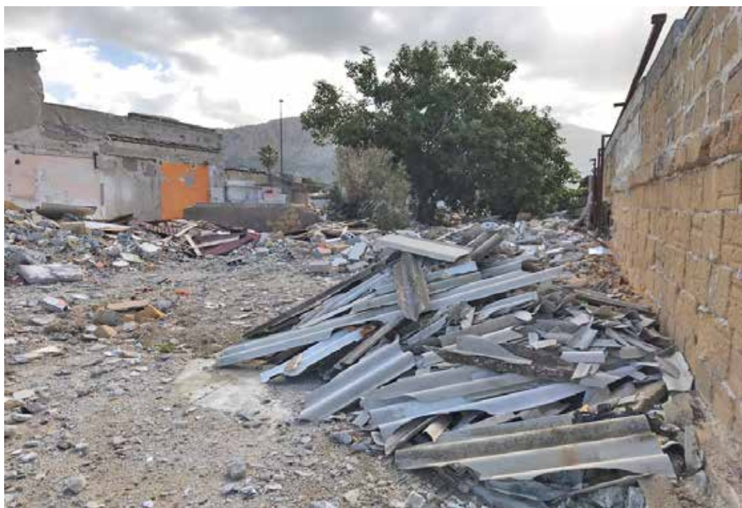
Carini - lungomare - demolizione immobili abusivi - rifiuti pericolosi
