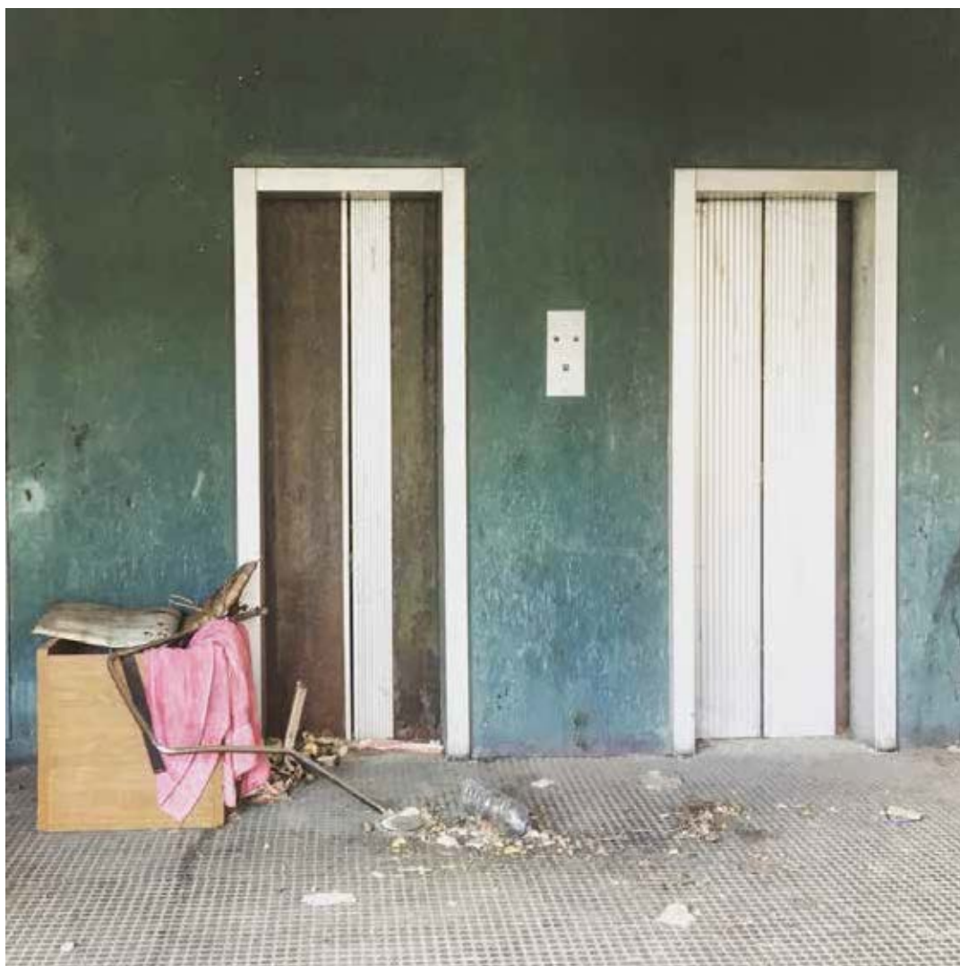
Calderara di Reno, complesso Garibaldi 2, blocchi 4, 5 e 6 oggetto di demolizione, interni area comune
