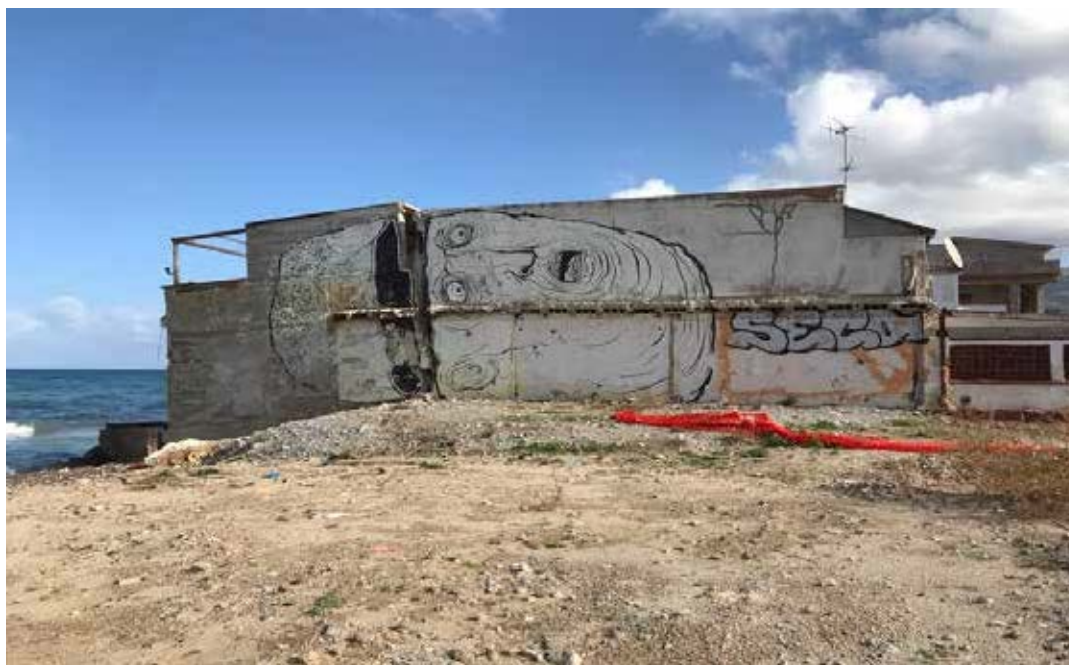
Carini - lungomare - edificio eroso e cadente
