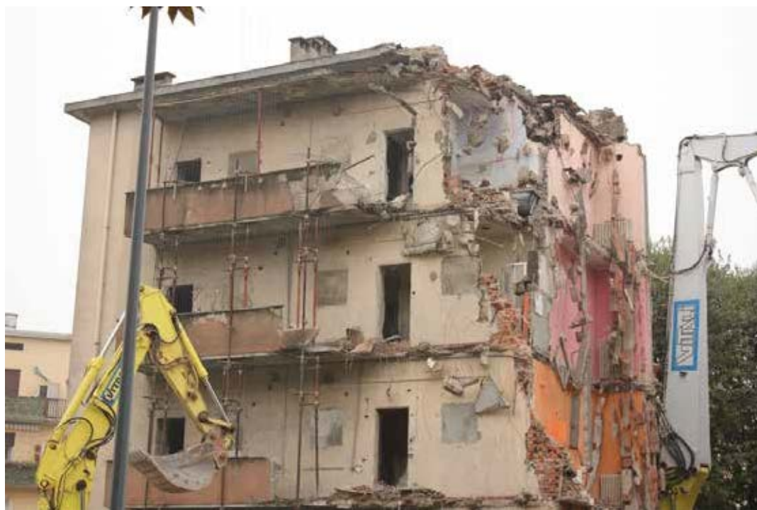
Giambellino - Lorenteggio (demolizione)
