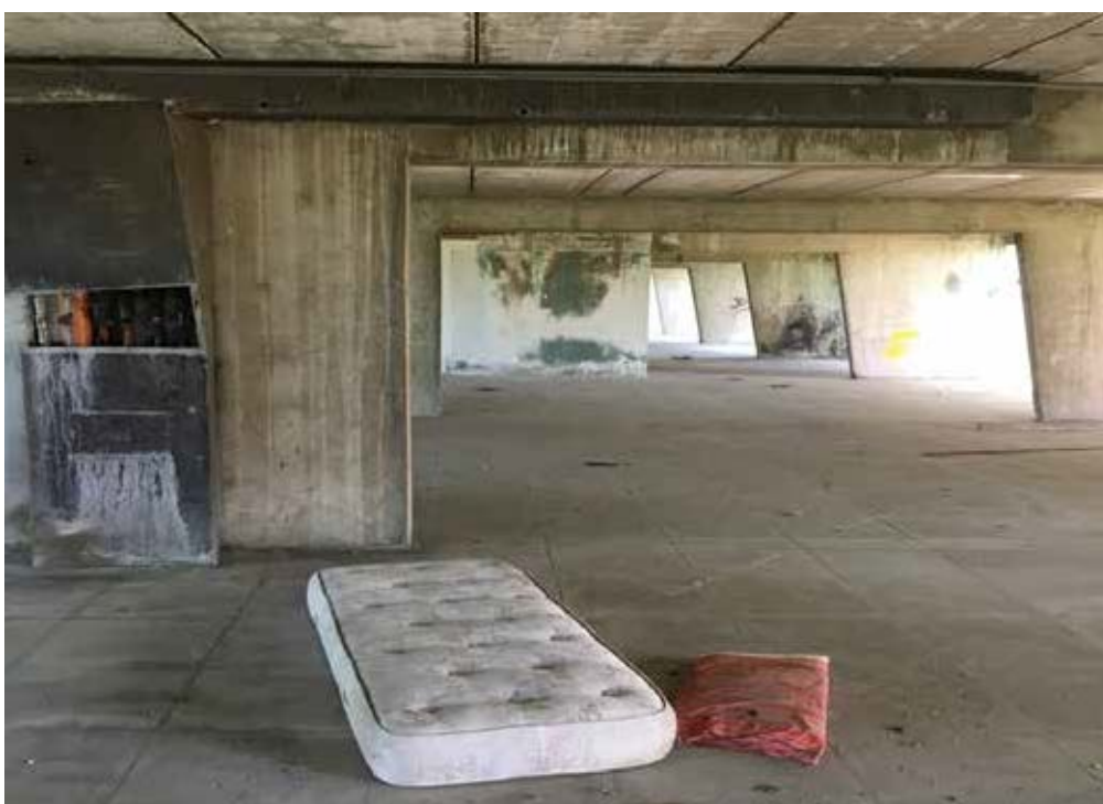
Calderara di Reno, complesso Garibaldi 2, blocchi 4, 5 e 6 oggetto di demolizione, piano terra
