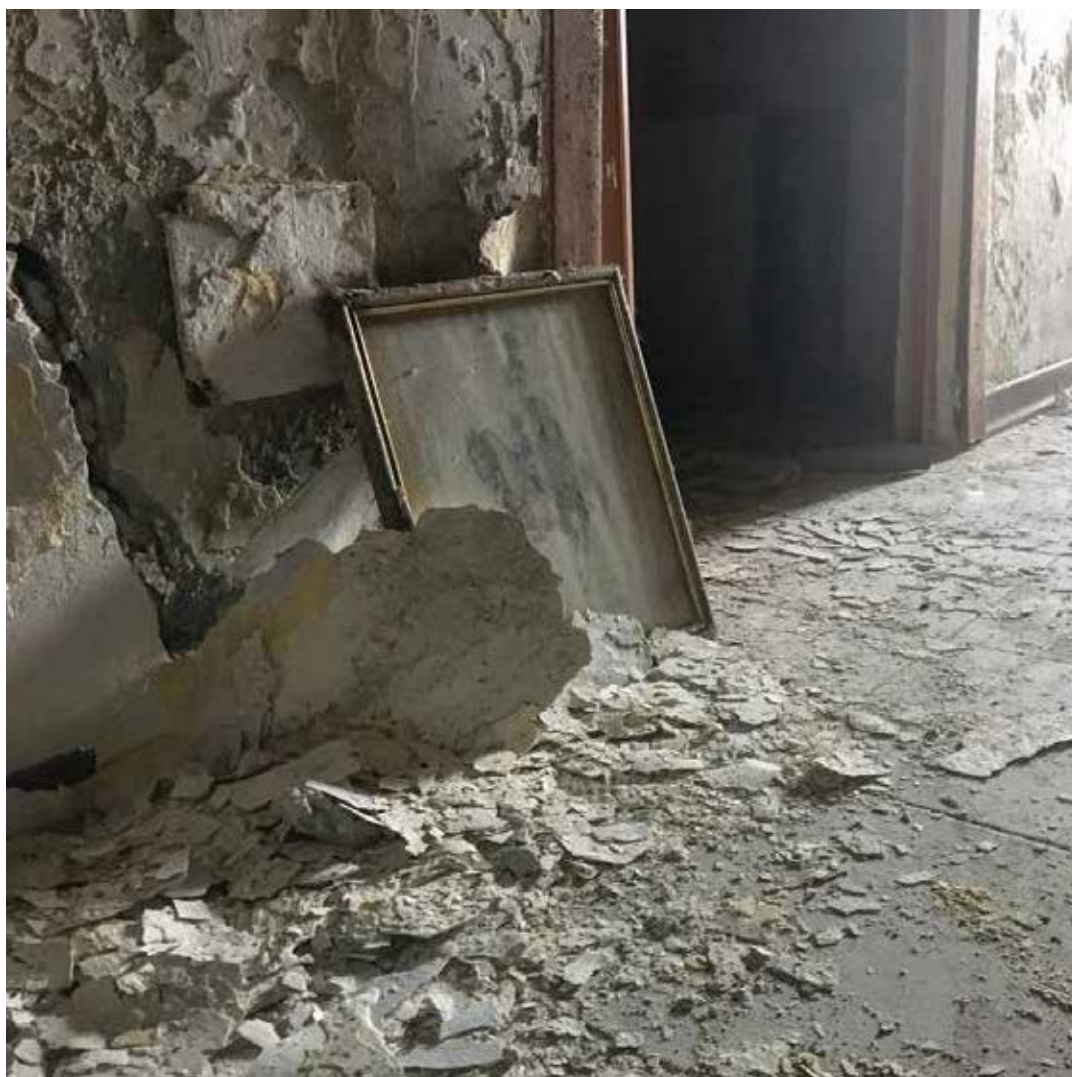
Calderara di Reno, complesso Garibaldi 2, blocchi 4, 5 e 6 oggetto di demolizione,
