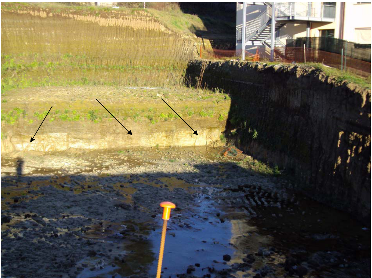
Fig. 8 – Vista dello scavo nell'area di studio, le frecce indicano l'ignimbrite alla base dello scavo
