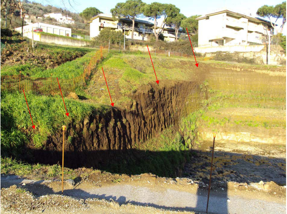
Fig. 6 – Vista della scarpata (indicata dalle frecce) oggetto di fenomeni di franosità in atto e potenziali
